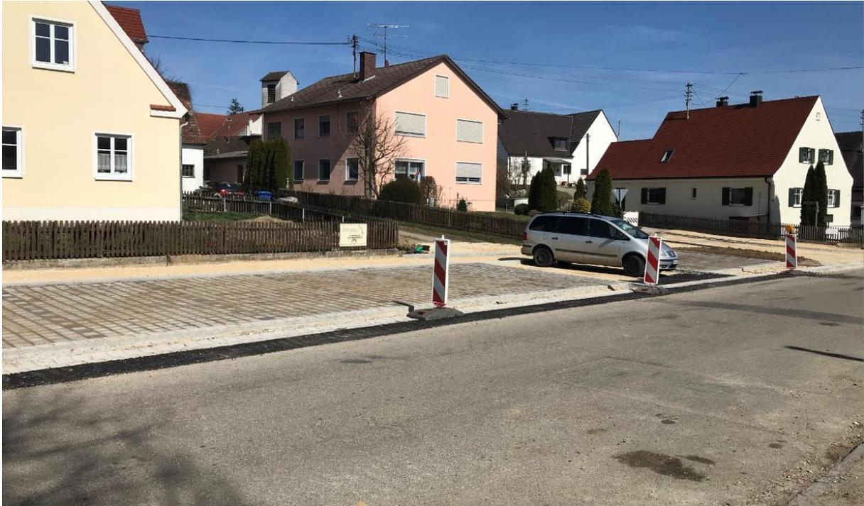
Die Deckschicht in der Schmiedstraße wird zusammen mit der Belagserneuerung der Kreisstraße in diesem Bereich durchgeführt.
